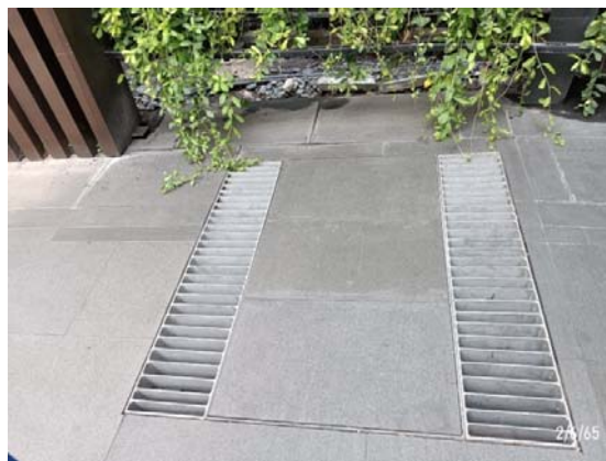
รูปที่ 2-18 ท่อระบายน้ำฝนของโครงการ
