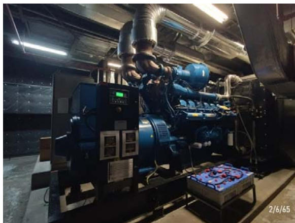
รูปที่ 2-28 เครื่องกำเนิดไฟฟ้าสำรอง
