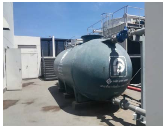
รูปที่ 2-16 ถังสำรองน้ำใช้ชั้นใต้ดิน และชั้นตาดฟ้า
